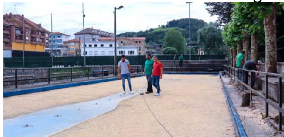
El alcalde de Hazas de Cesto, Alejandro Llano inspecciona la obra.
