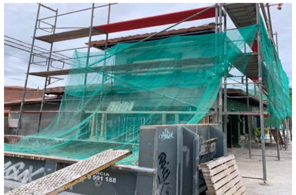
Avanzan a buen ritmo las obras de la antigua Platería.
