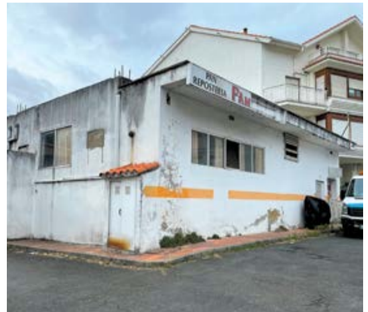
Edificio recién adquirido por el Ayuntamiento.
