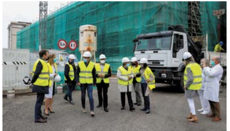
Asistentes a la visita realizada al Hospital de Laredo.
