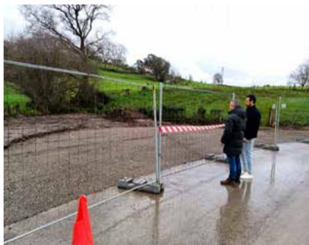
Alejandro Llano y Enrique Lastra, supervisan las obras.
