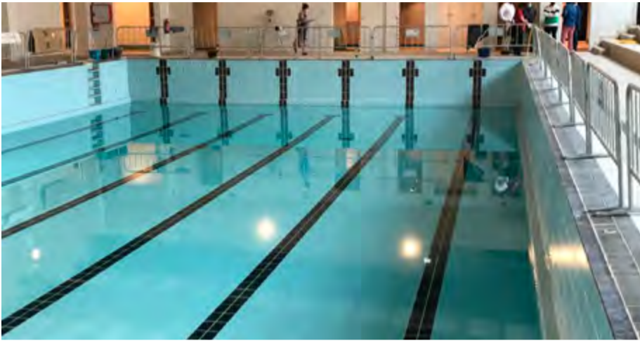
El ayuntamiento de laredo recepciona las obras de la piscina municipal.
