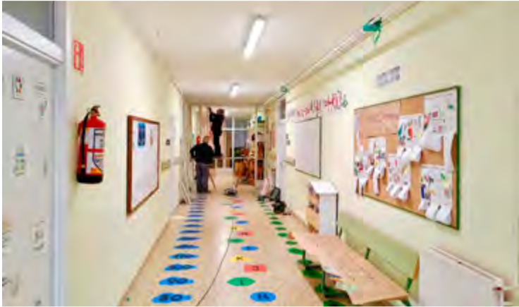
Los operarios realizando las labores de mejora en el colegio Jesús del Monte.
