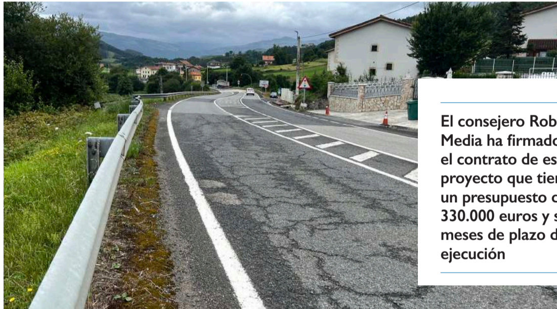
Tramo de la CA-268 donde se ejecutará la actuación.
