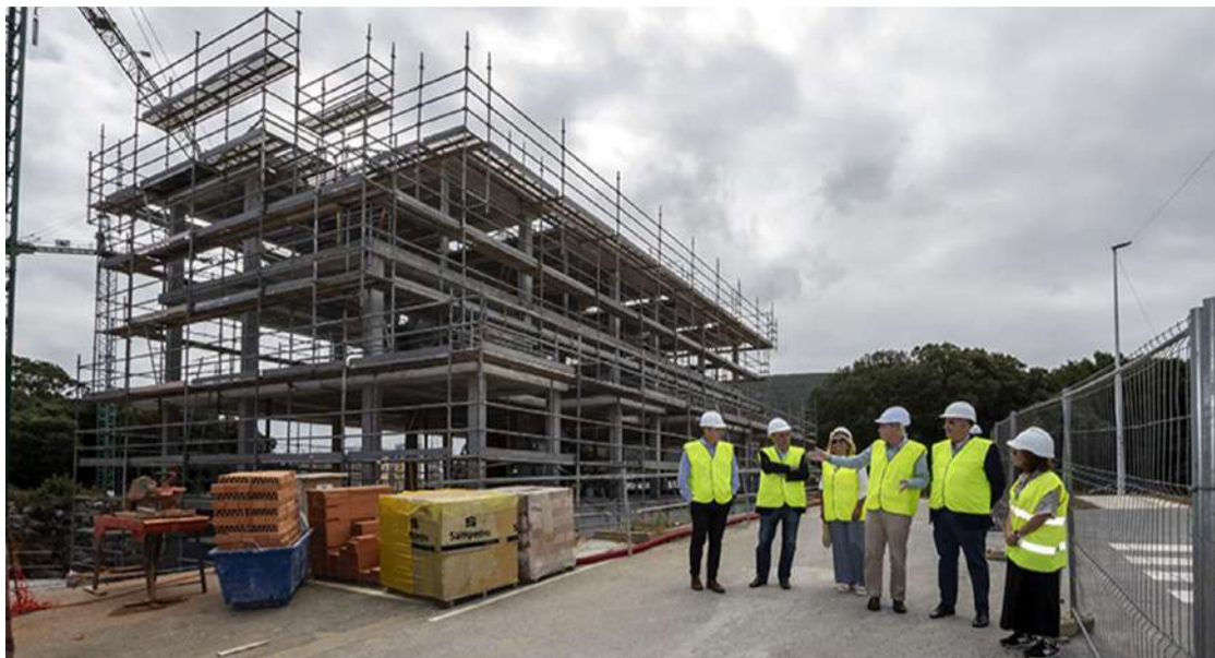
Un momento de la visita a las obras de las viviendas de La Arena.
