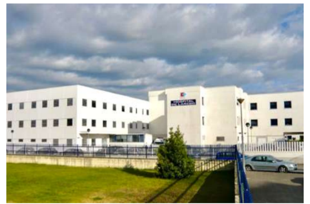
Hospital de Laredo.
