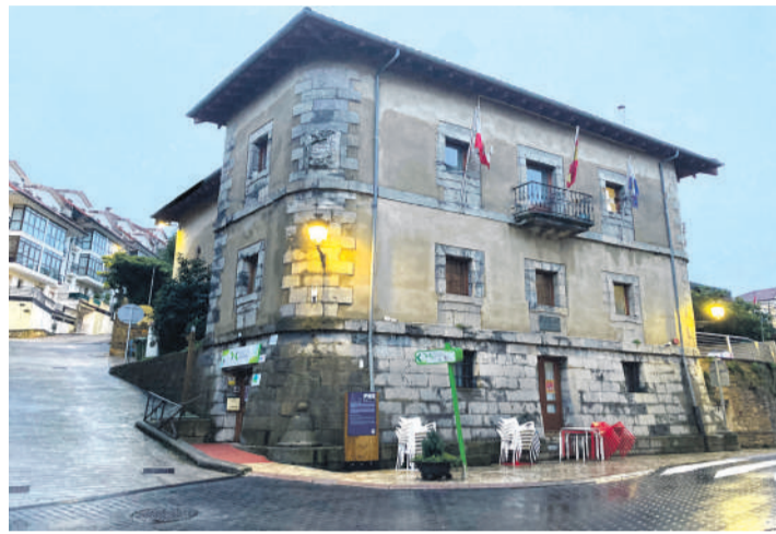
La intervención va a permitir una optimización de los espacios, dando lugar a un área de Biblioteca infantil
