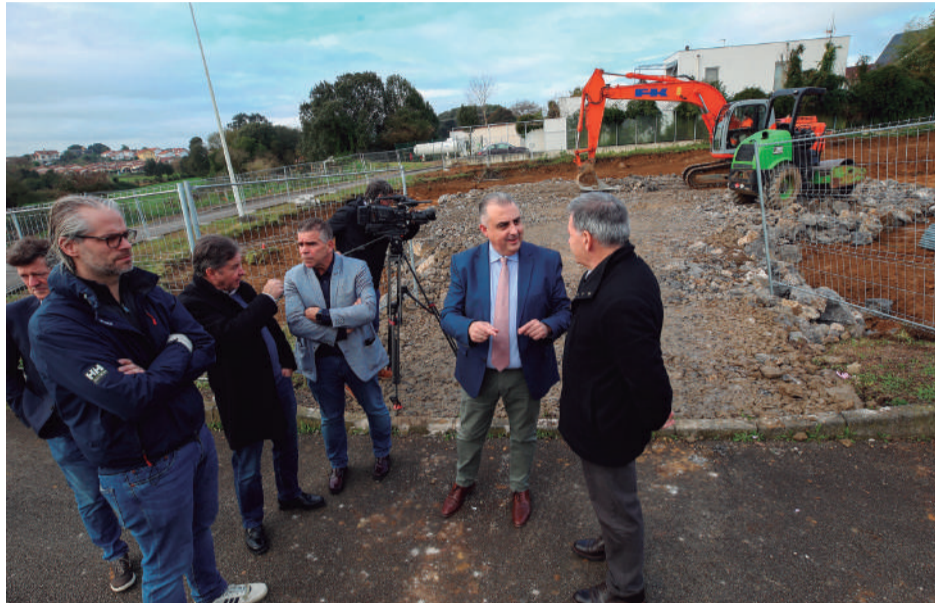
El consejero ha visitado, junto a Barruetabeña, el inicio de las obras de las nuevas viviendas.
