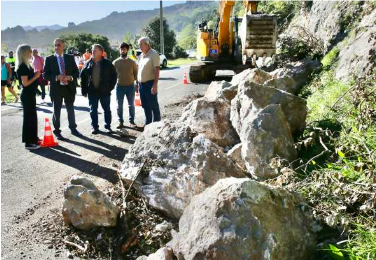
Zona en la que se han iniciado las obras de consolidación de taludes.
